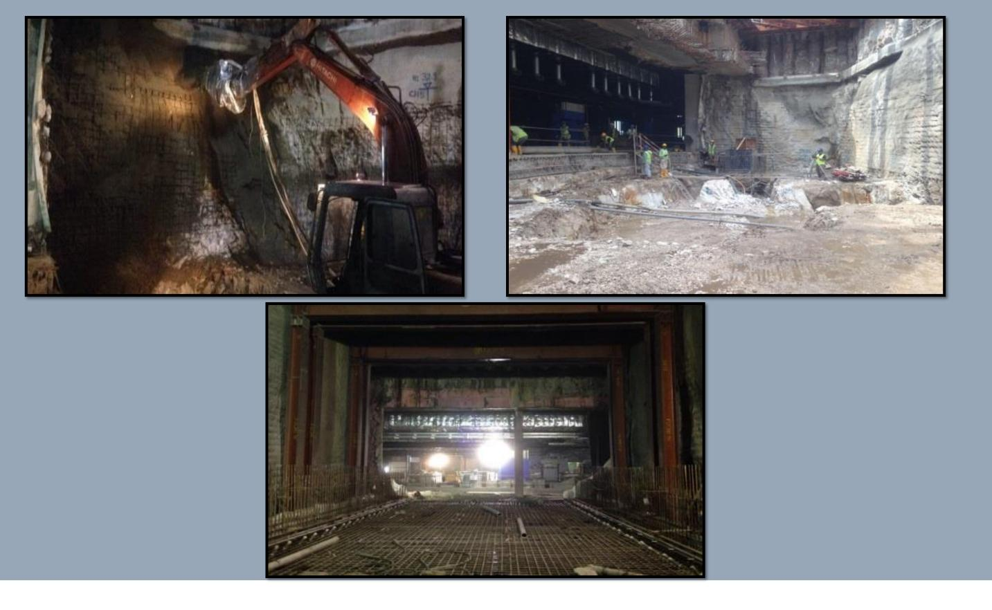
PROJECT MASS RAPID TRANSIT LEMBAH KELANG – JAJARAN SG.BULOH – KAJANG UNDERGROUND WORKS : CONSTRUCTION AND COMPLETION OF UNDERGROUND EXCAVATION AND **STRUTTING FOR MALURI ENTRANCE A & D**
